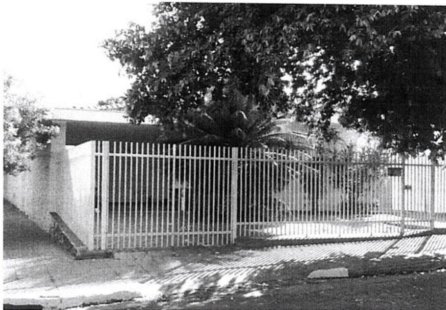
Localização SRT Casa do Beija Flor: Rua Torres Homem, nº 922 - Vila Estádio.
